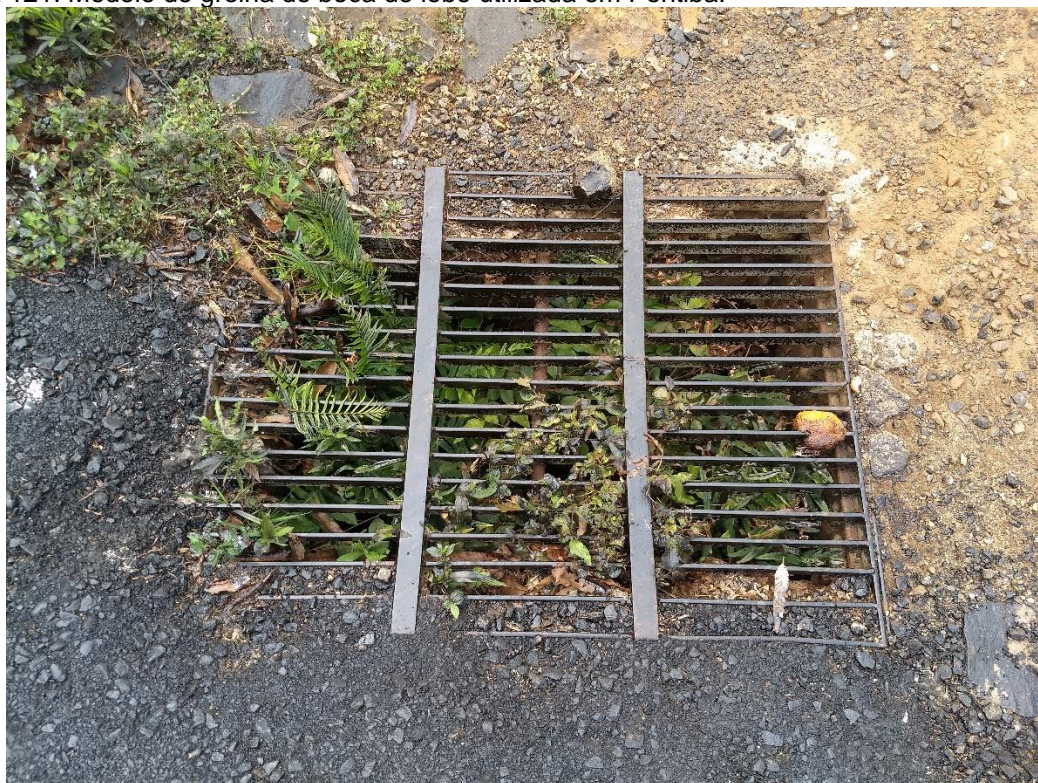
Figura 121: Modelo de grelha de boca de lobo utilizada em Peritiba.
