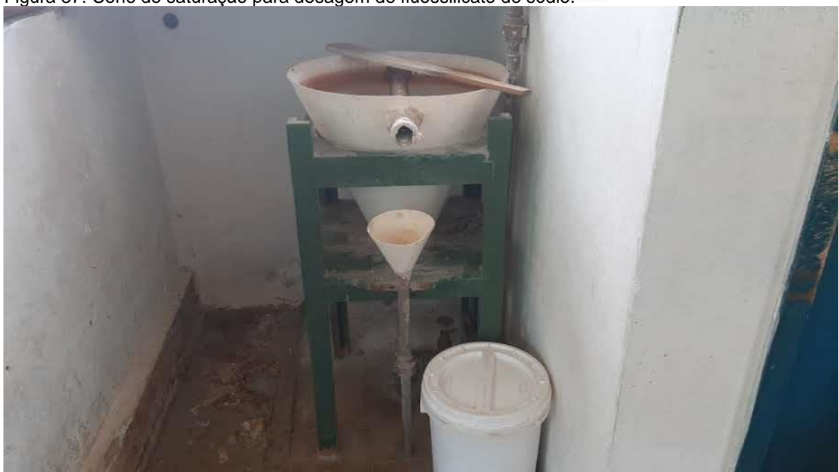
Figura 37: Cone de saturação para dosagem de fluossilicato de sódio.
