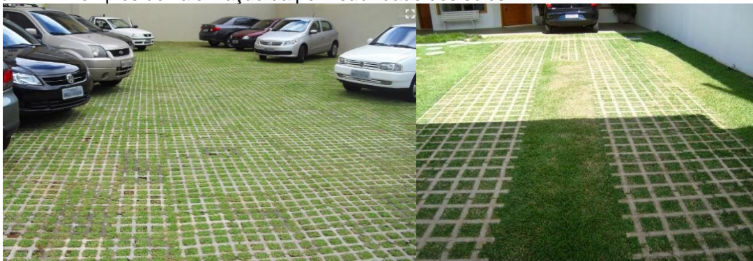
Figura 141: Exemplos de valorização da permeabilidade dos solos.
