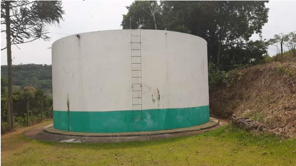
Figura 41: Centro de reservação R1 – 250m 3 .
