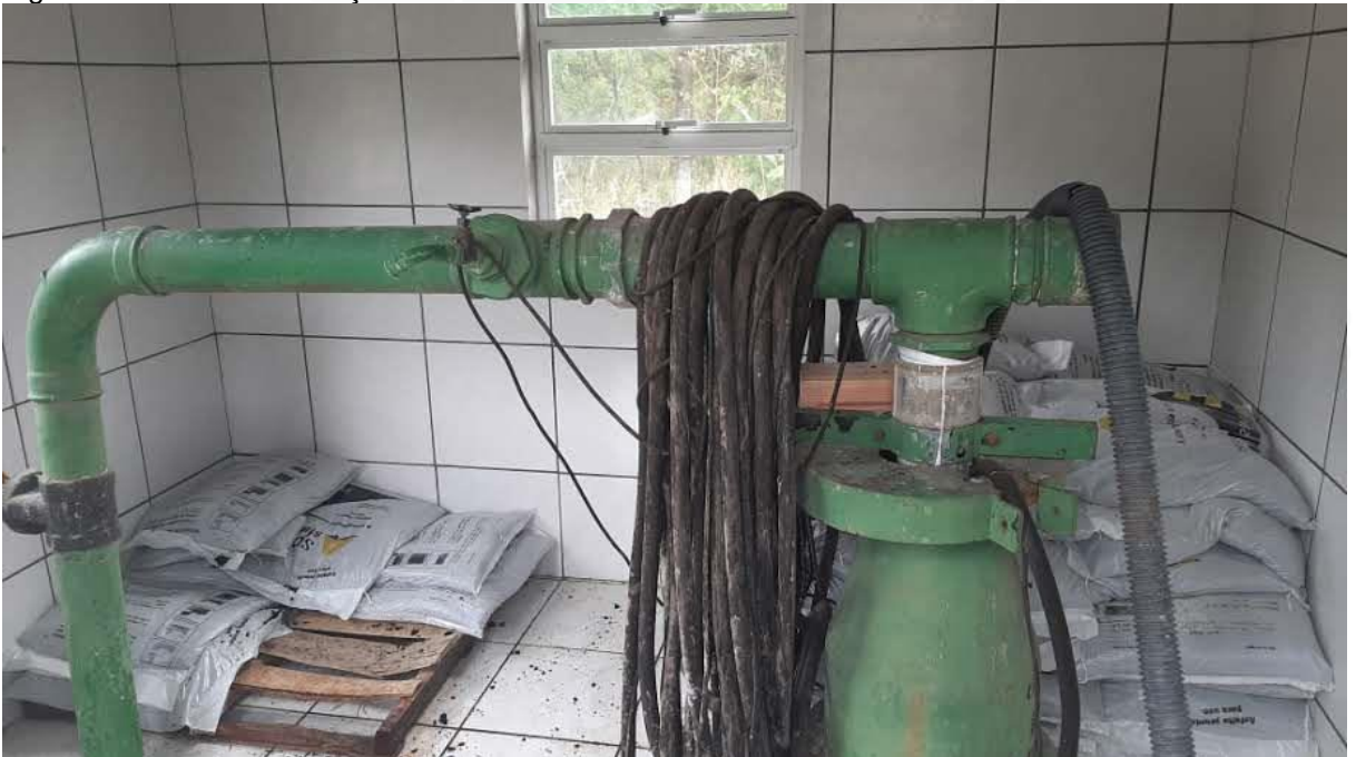
Figura 30: Cavalete do Poço 01 – Armazenamento de materiais ao fundo.
