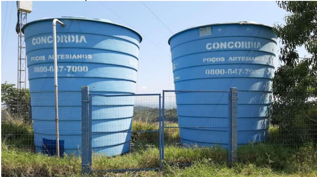
Figura 61: Centro de reservação R3.
