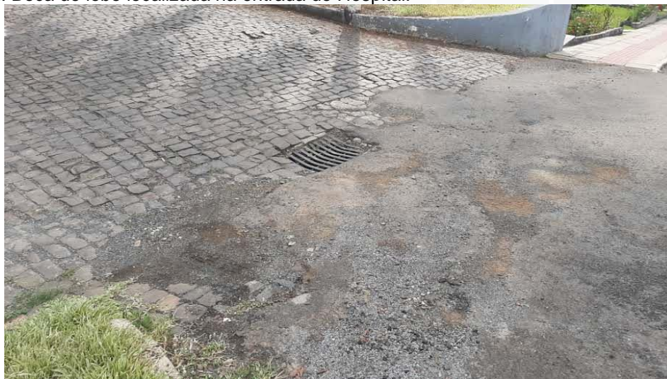
Figura 132: Boca de lobo localizada na entrada do Hospital.
