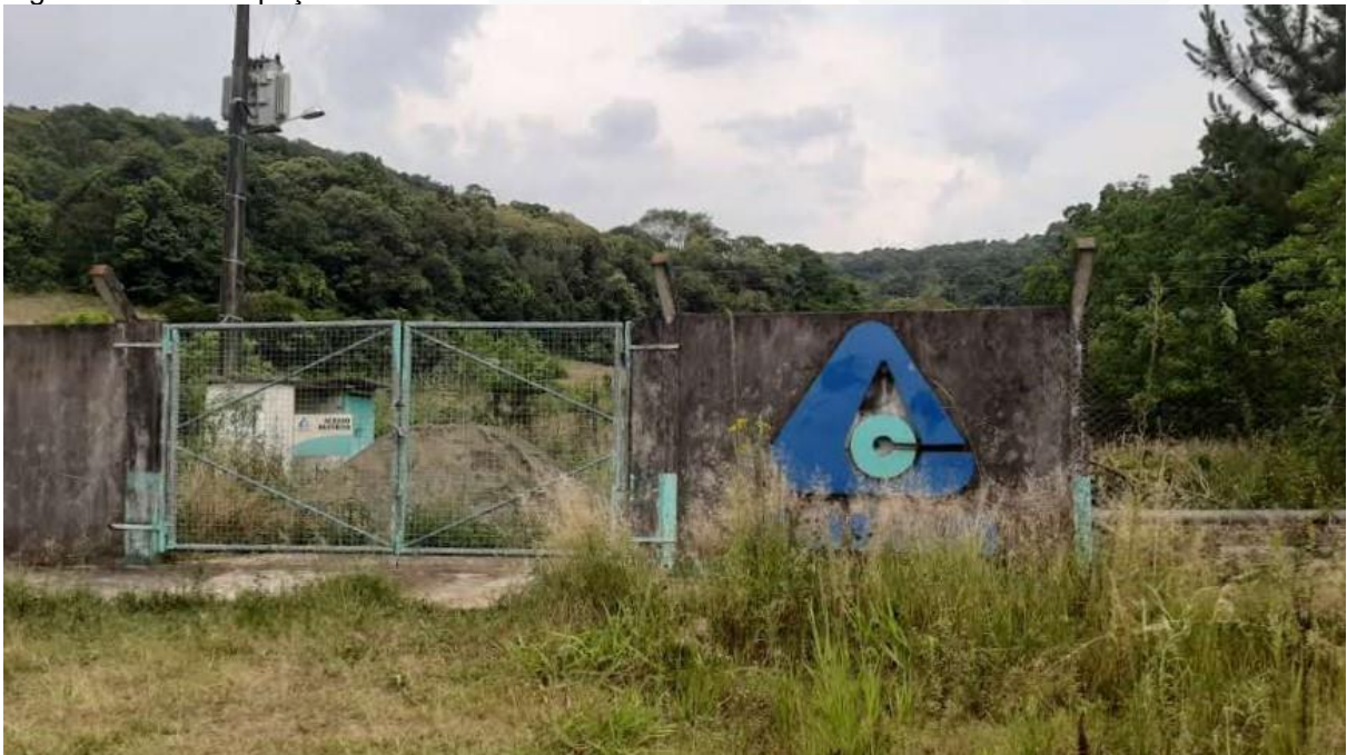
Figura 28: Área do poço 01.
