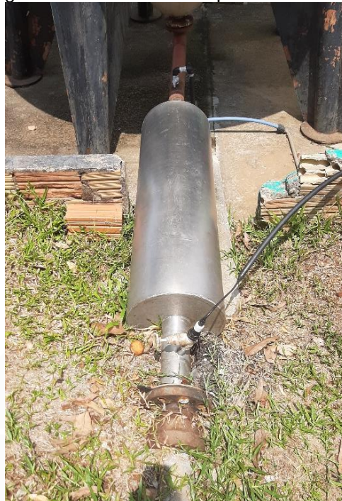
Figura 33: Turbo reator – dosagem de PAC e mistura rápida.
