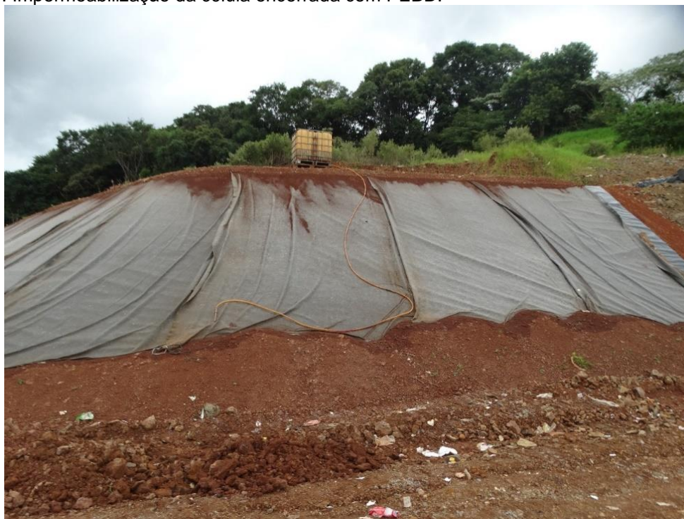
Figura 91: Impermeabilização da célula encerrada com PEBD.
