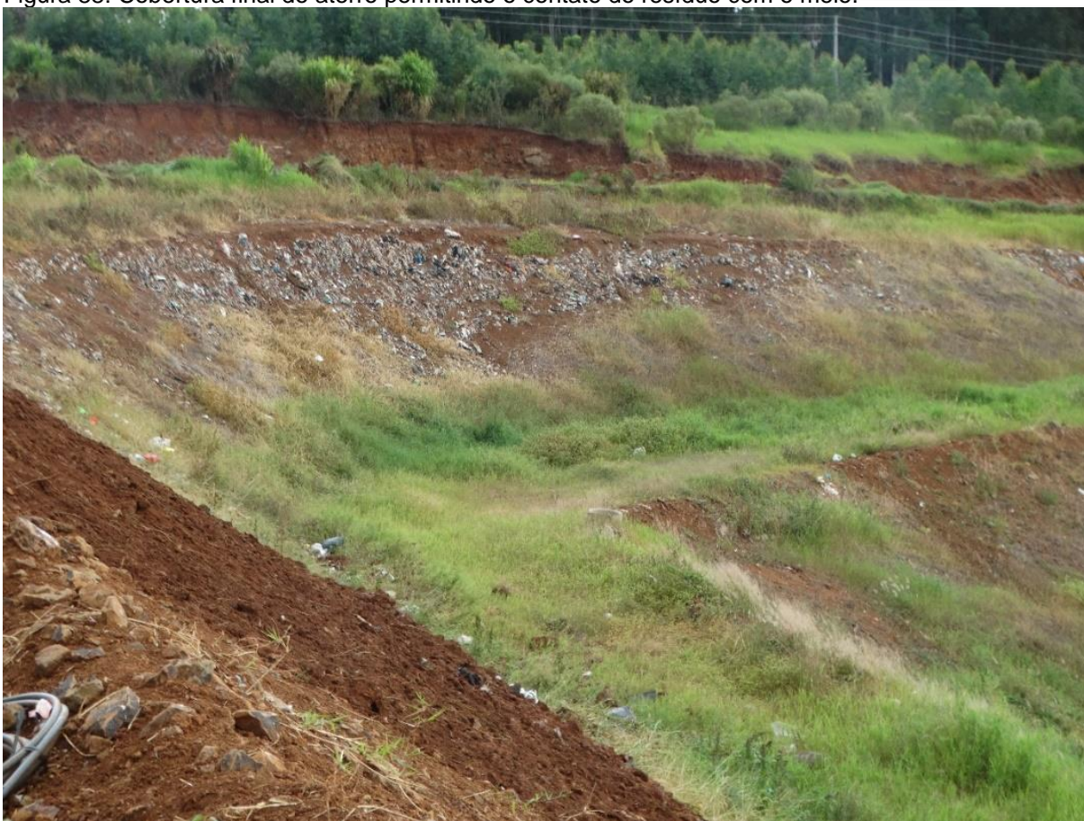
Figura 88: Cobertura final do aterro permitindo o contato do resíduo com o meio.
