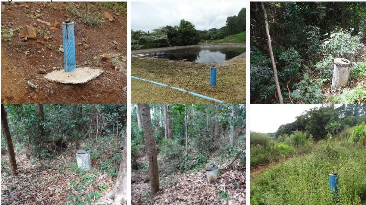
Figura 99: Poços de monitoramento instalados na área do aterro.
