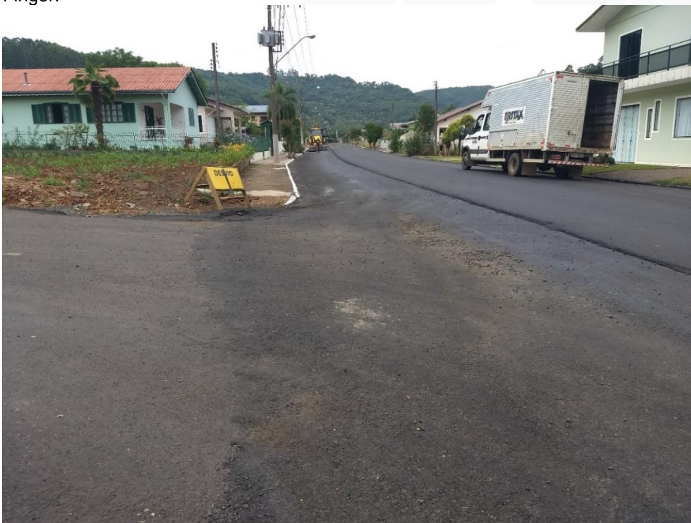
Figura 126: Ponto com alagamento na Rua Senador Irineu Bornhausem com a Rua Rudi Wilibaldo Finger.
