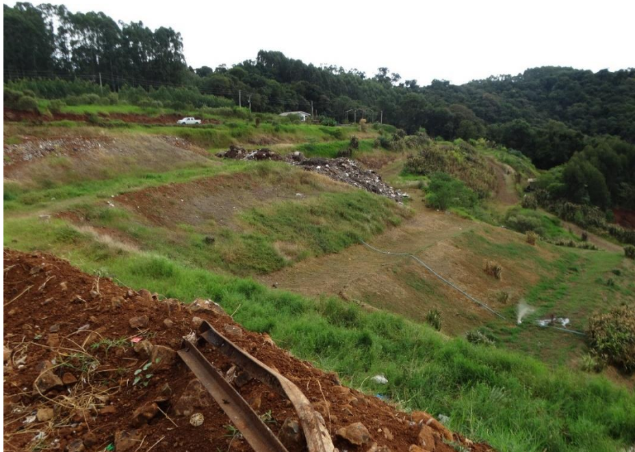
Figura 98: Sistema de recirculação de efluentes no aterro.
