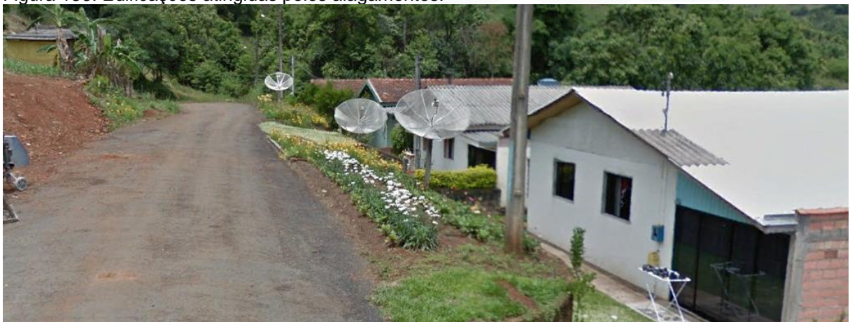
Figura 136: Edificações atingidas pelos alagamentos.
