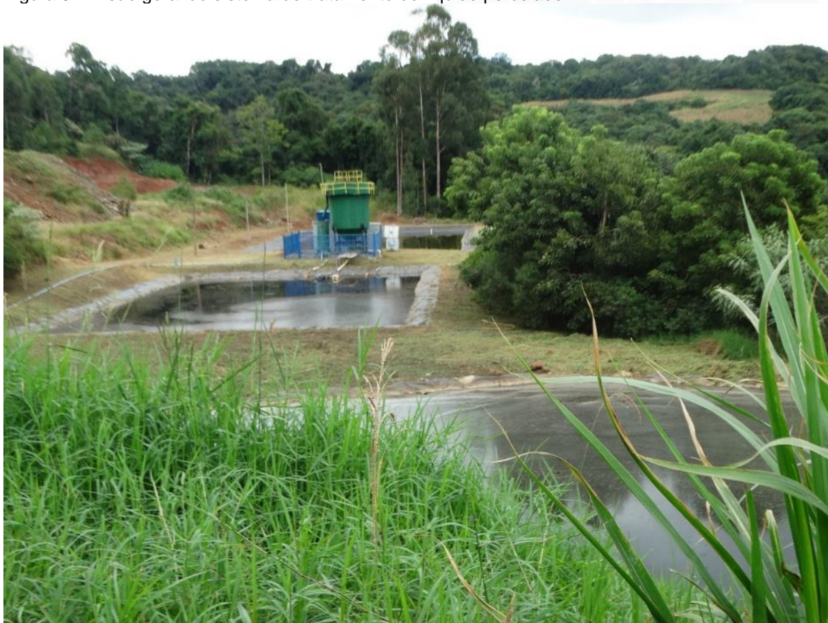
Figura 97: Visão geral do sistema de tratamento do líquido percolado.
