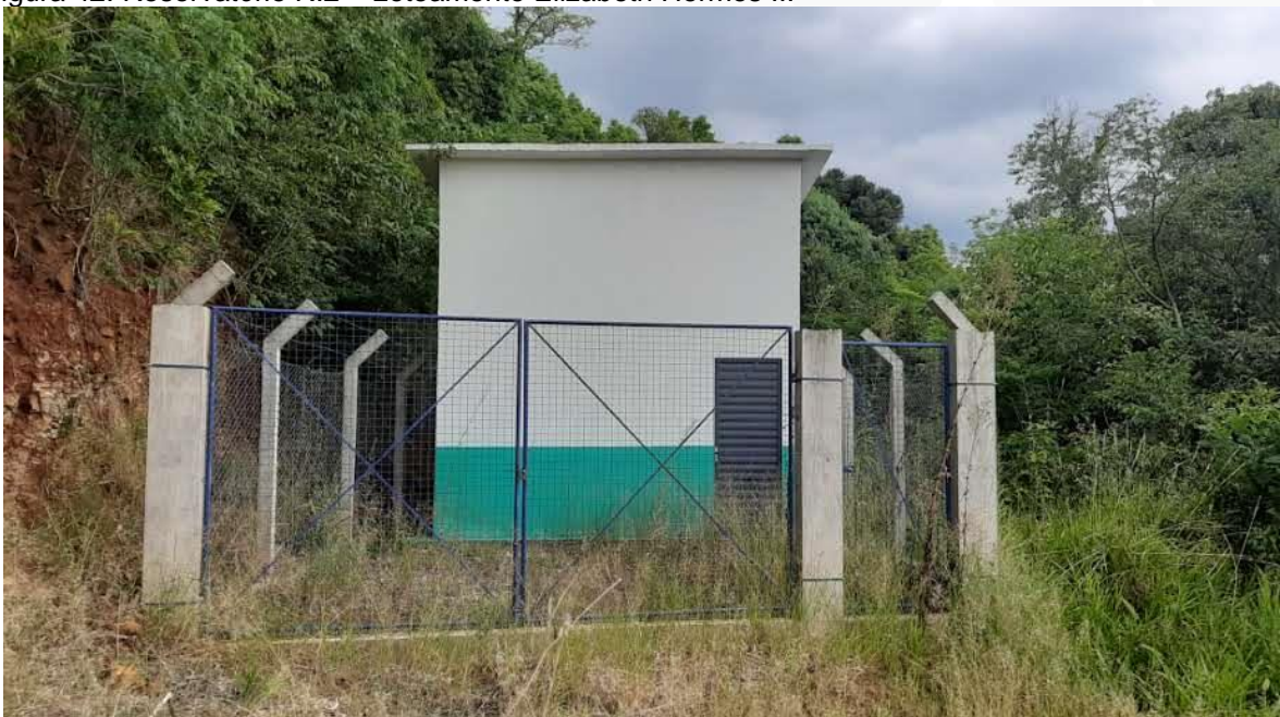
Figura 42: Reservatório R.2 – Loteamento Elizabeth Hermes II.
